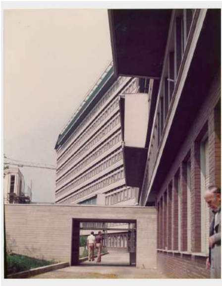
Foto di cantiere del centro oncologico presso l'ospedale S. Chiara di Trento, primi anni Settanta
